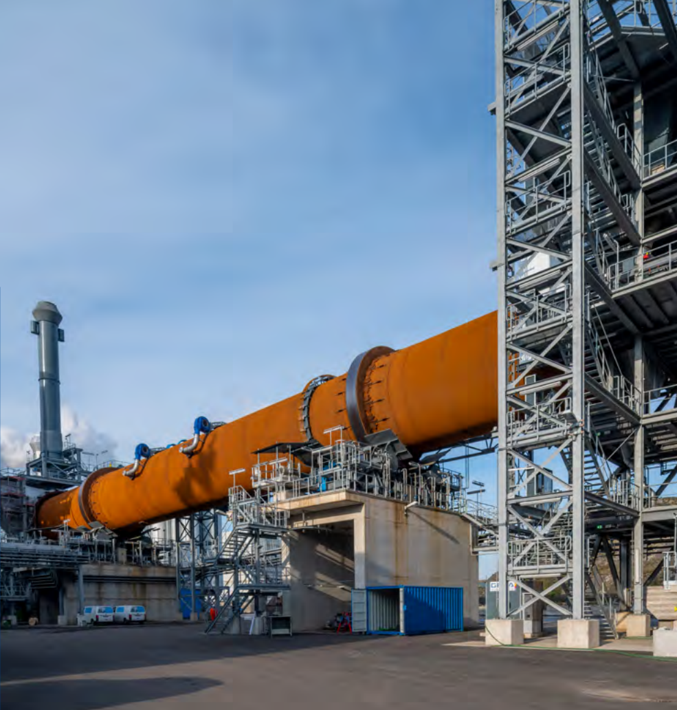
REKO installatie, Botlek Rotterdam.
