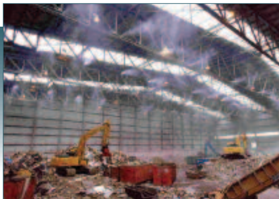
Stofbepanking met nevel voor hallen, bunkers, shredders/brekers en transportbanden
